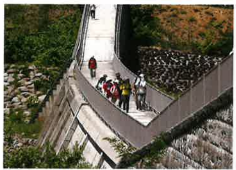
大暗きよ砂防堰堤
