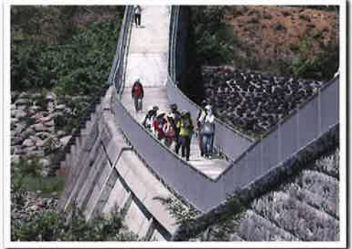
大暗きよ砂防堰堤
